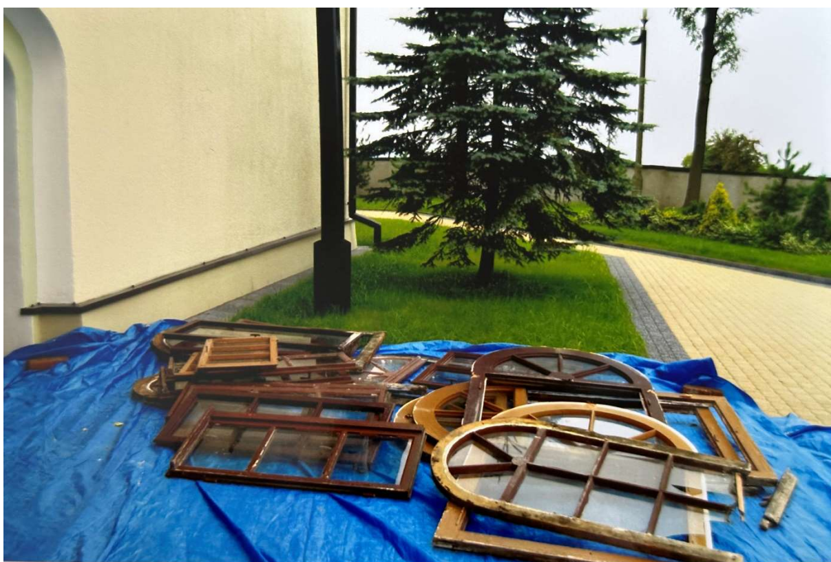
Fot. 4. Zdemontowana stolarka okienna w trakcie remontu w 2011 roku.
