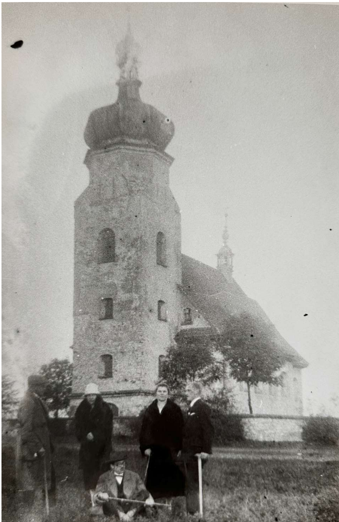
Fot. 7. Fotografia archiwalna. Widok kościoła z około 1930-1940 r.
