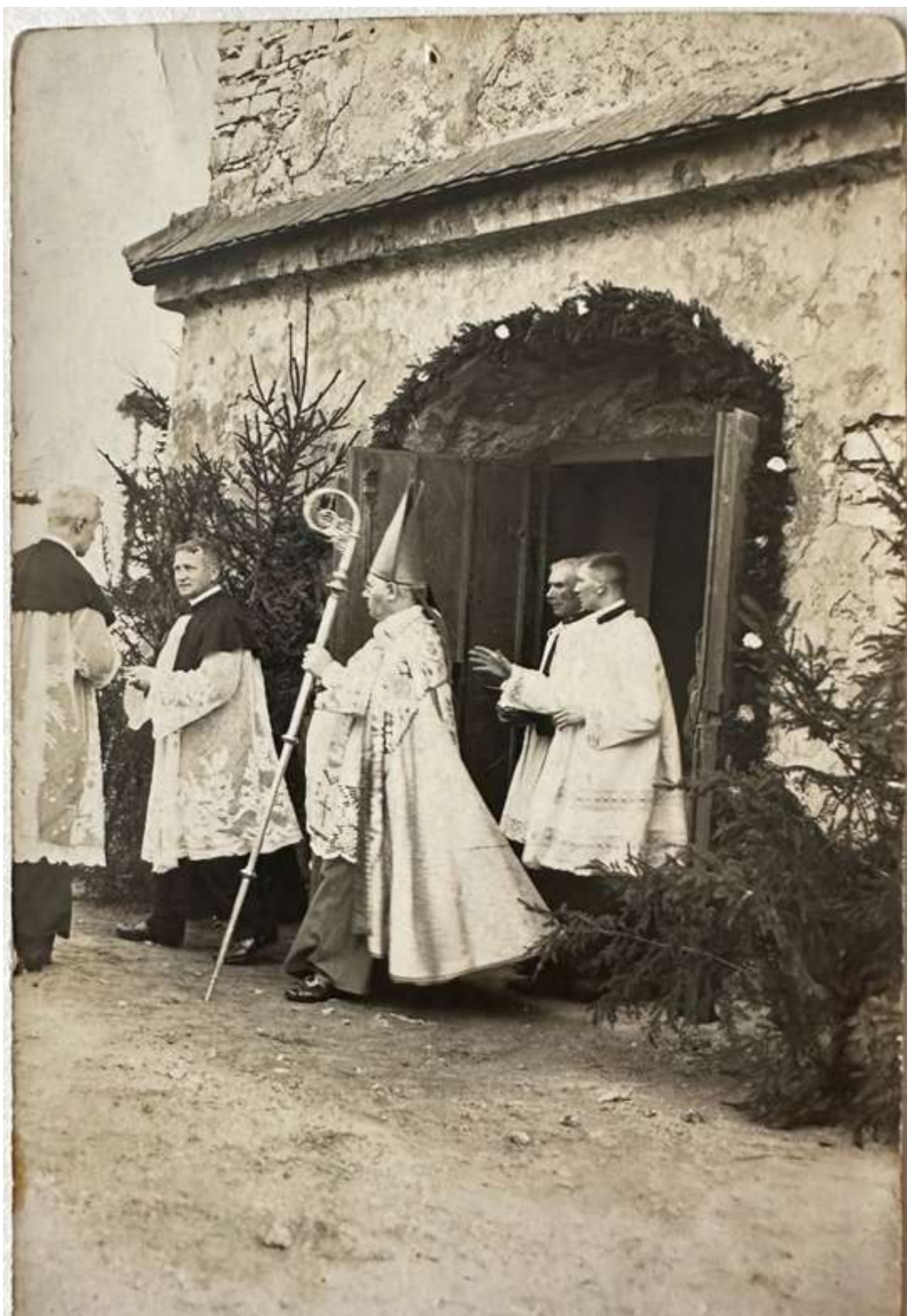
Fot. 8. Fotografia archiwalna. Widok kościoła z około 1930-1940 r.
