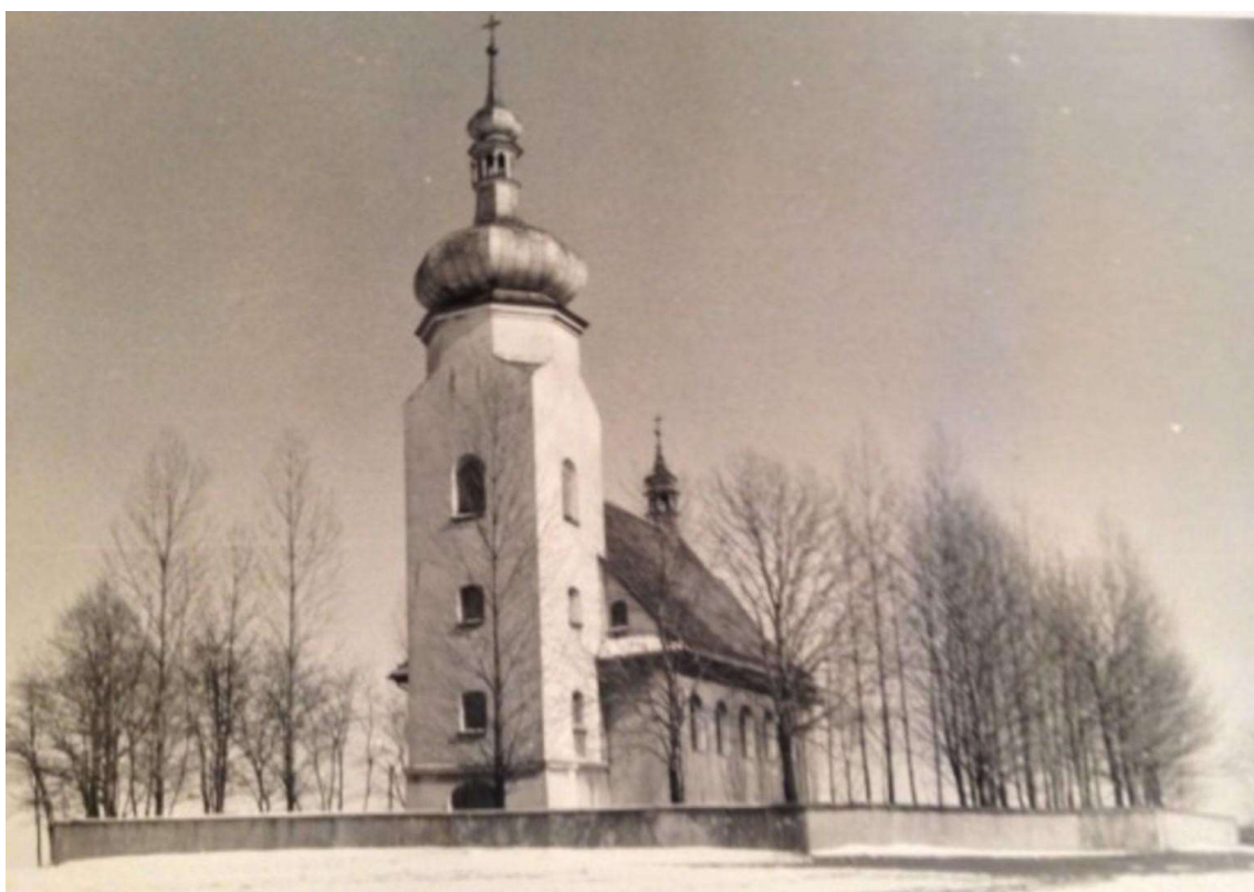
Fot. 12. Fotografia archiwalna. Widok kościoła z około 1930-1949 r.
