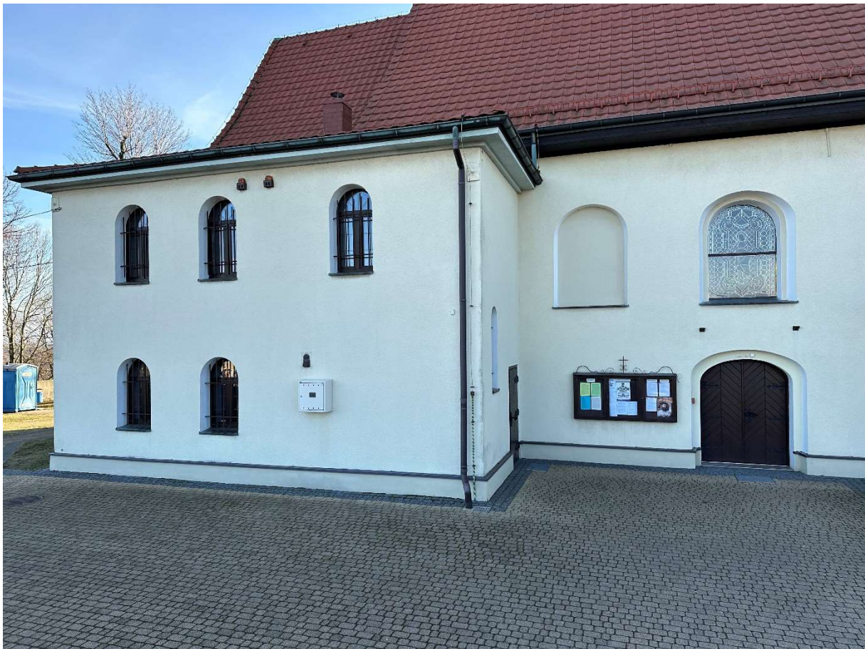
Fot. 30. Widok na zakrystię i dach kościoła.
