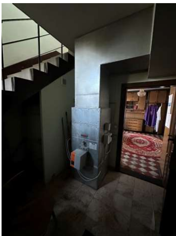
Fot. 18 A,B. Piec i zbiorniki na olej opałowy (A). Instalacja do rozprowadzenia ciepłego powietrza(B).
