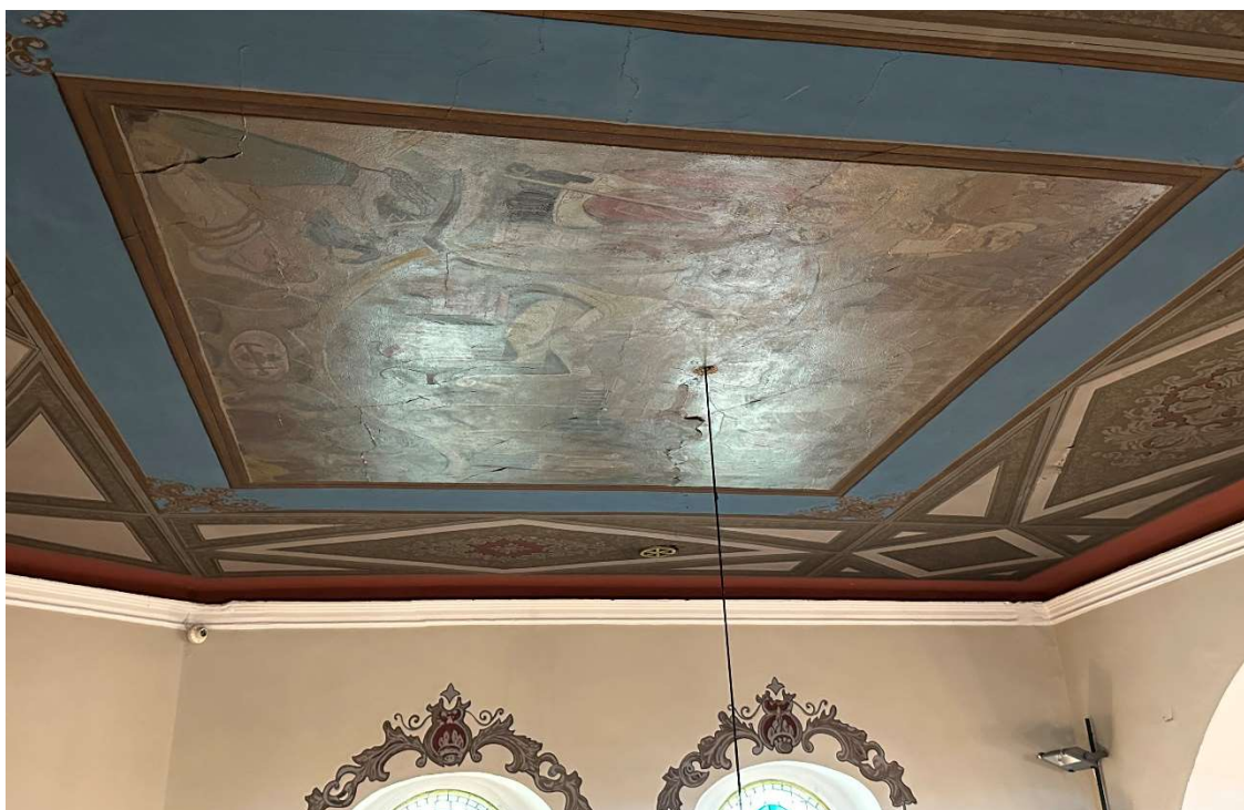
Fot. 24. Gzyms pod stropem, nad którym istnieje przestrzeń do zamontowania dodatkowych otworów nawiewu.
