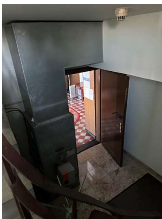
Fot. 18 A,B. Piec i zbiorniki na olej opałowy (A). Instalacja do rozprowadzenia ciepłego powietrza(B).
