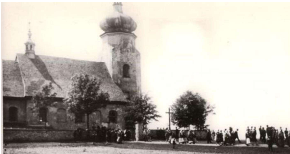
Fot. 10. Fotografia archiwalna. Widok kościoła z około 1930-1940 r.
