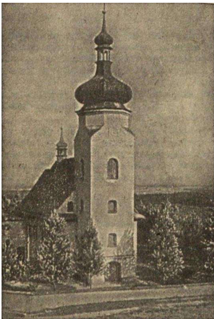
Fot. 9. Fotografia archiwalna. Widok kościoła z około 1945-1946 r.
