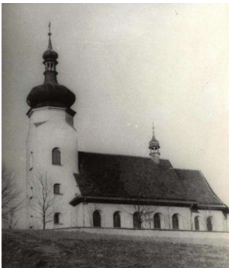
Fot. 11. Fotografia archiwalna. Widok kościoła z około 1930-1940 r.
