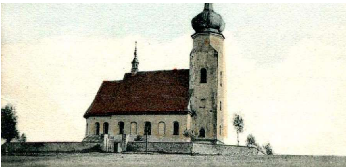
Fot. 4. Fotografia archiwalna. Widok kościoła z około 1906-1911 r.
