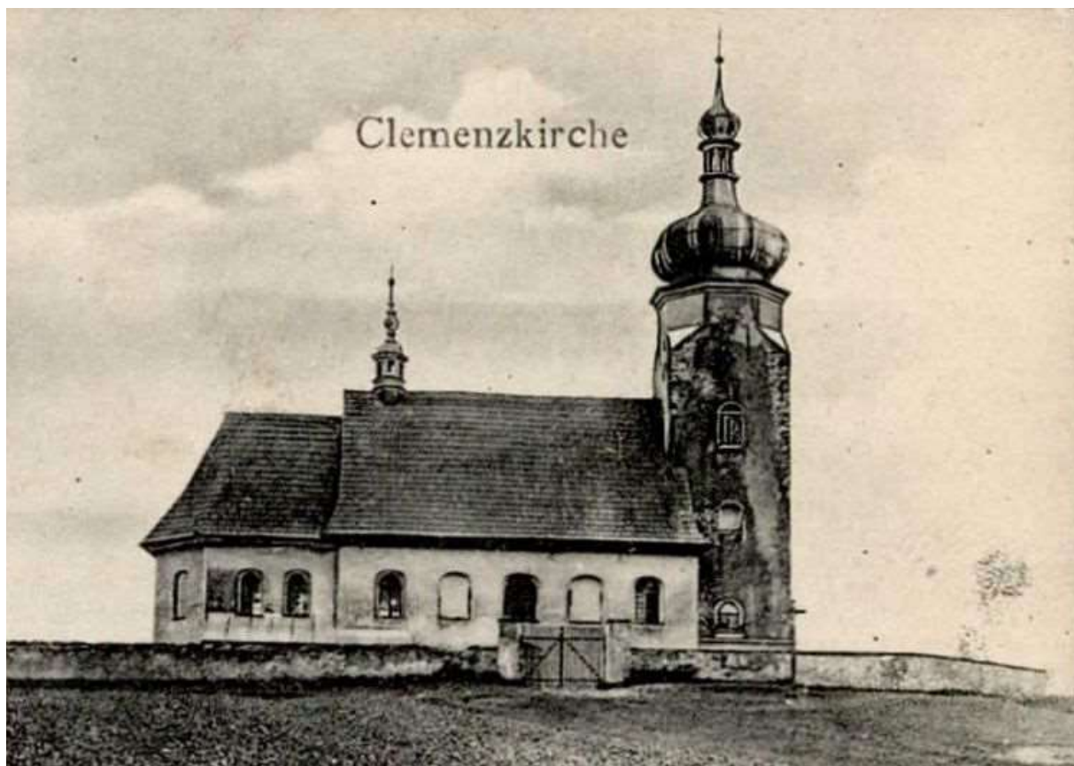
Fot. 5. Fotografia archiwalna. Widok kościoła z około 1915-1930 r.
