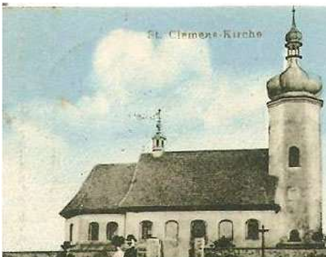
Fot. 3. Fotografia archiwalna. Widok kościoła z około 1900-1920 r.
