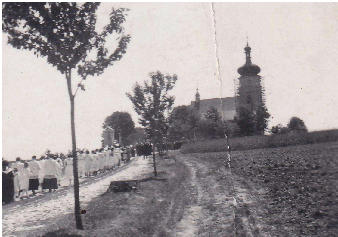
Fot. 6. Fotografia archiwalna. Widok kościoła z około 1930-1940 r.
