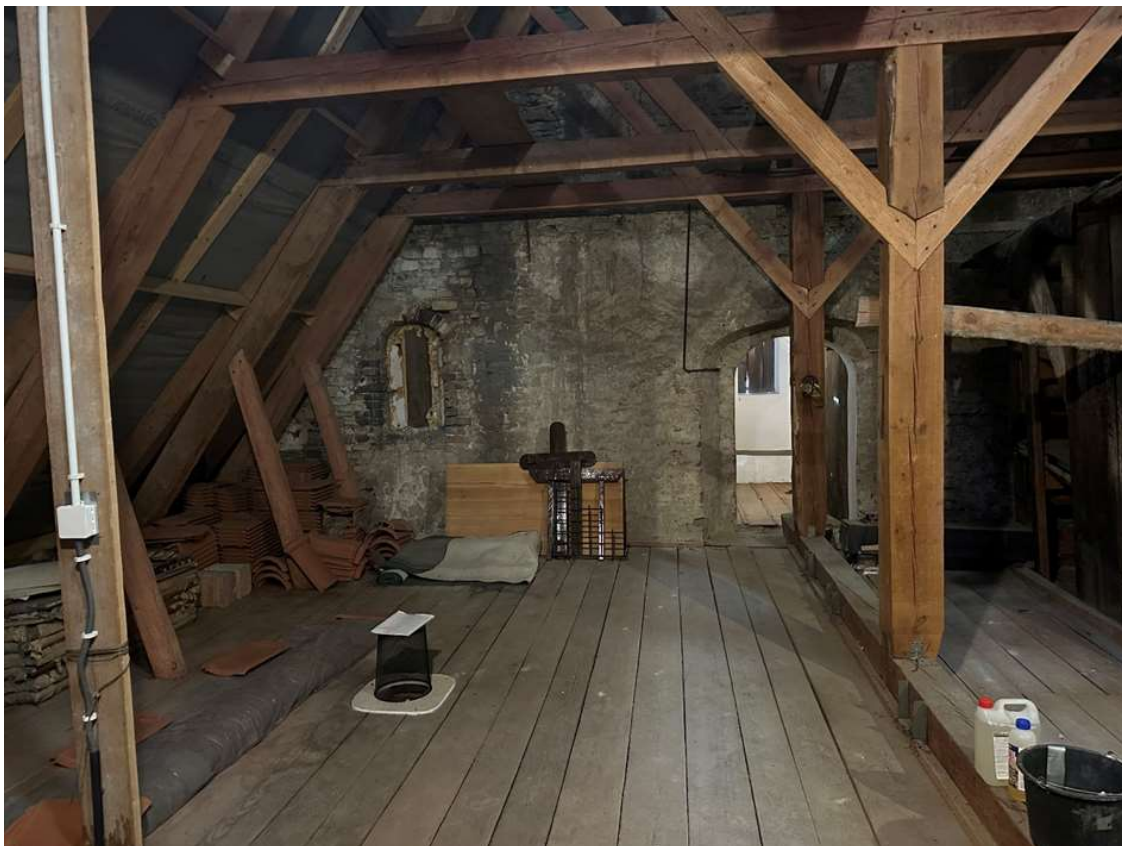
Fot. 21. Zaślepione okno obok wieży.
