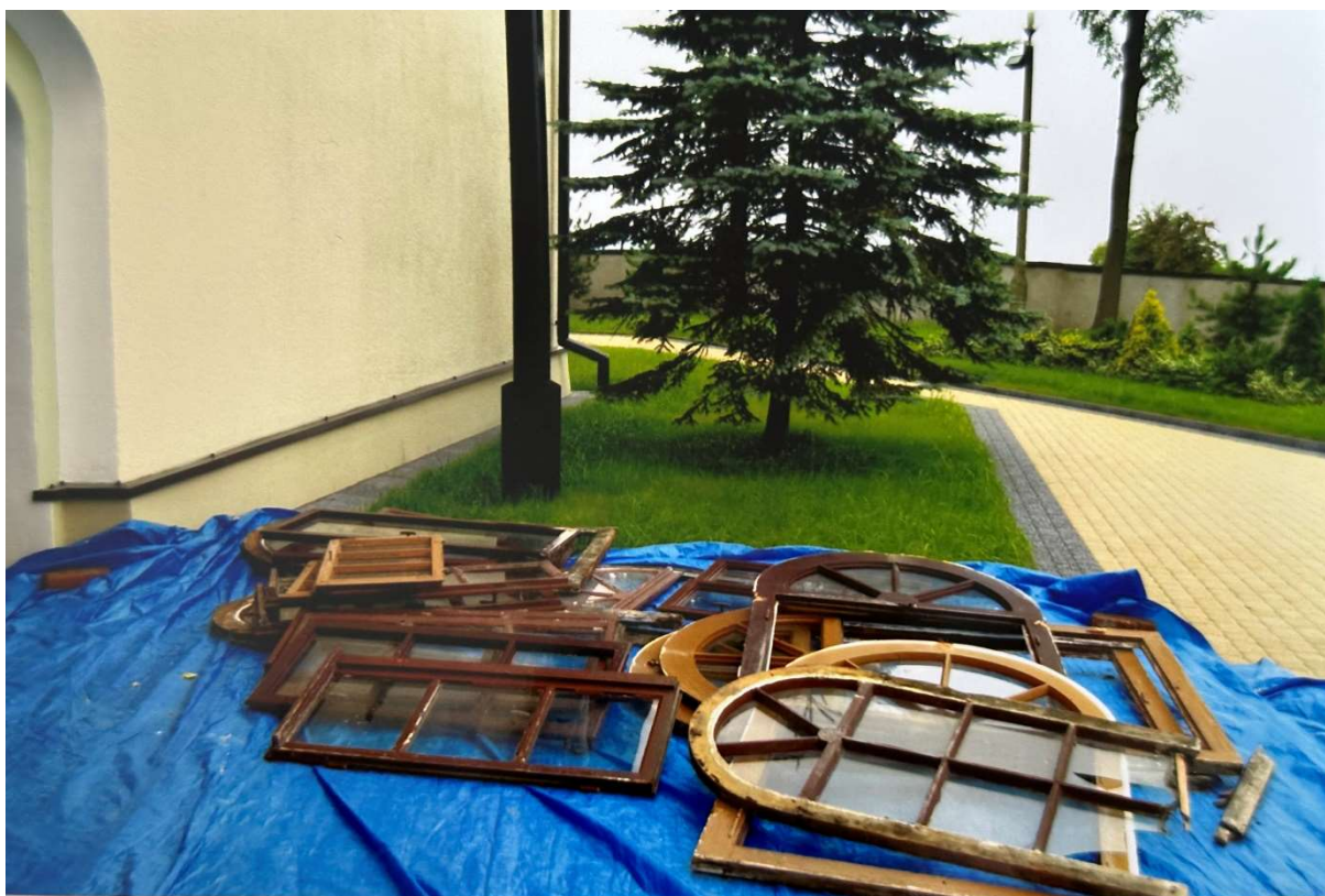
Fot. 28. Zdemontowana stolarka okienna w trakcie remontu w 2011 roku.
