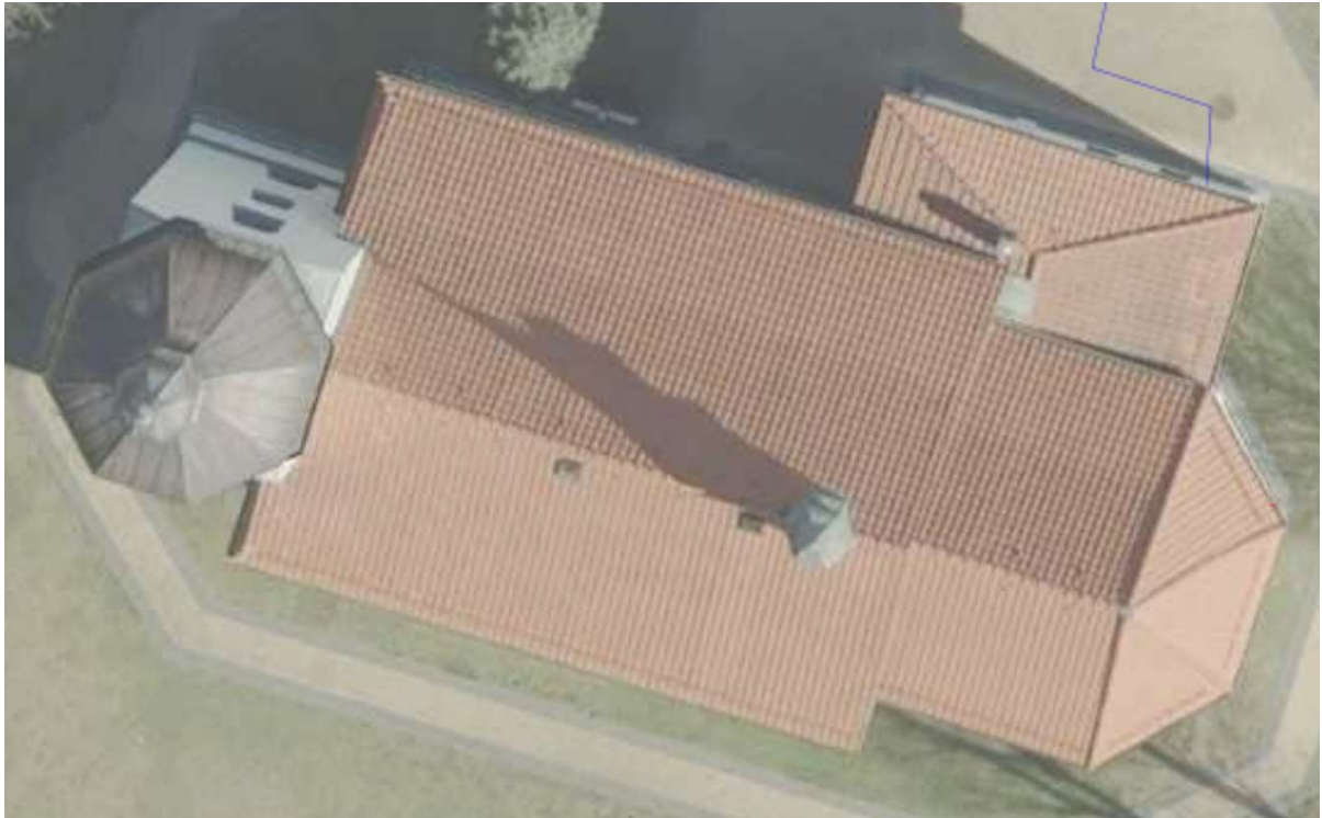
Fot. 29. Układ dachu nad zakrystią kościoła.
